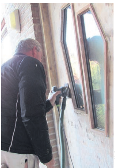
De kale ondergrond wordt mechanisch nagestuurd
